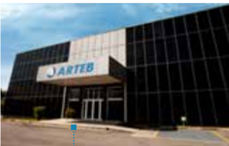
Centro Tecnológico / Tech Center 2000m 2
